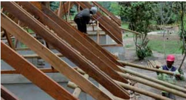
Figura 25. Varas de madera aserrada y aleros en rolliza.
